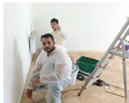
Junge Zuwanderer helfen bei der Renovierung von Wohnungen.
