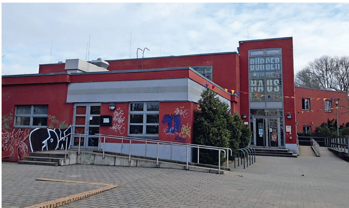
Abbildung 5: Außenansicht des Bürgerhauses am Schlaatz (Quelle: Stadtkümmerei)
