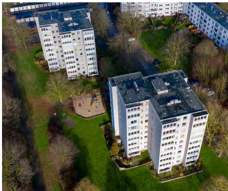
Die Hochhäuser am Esbergweg von oben
