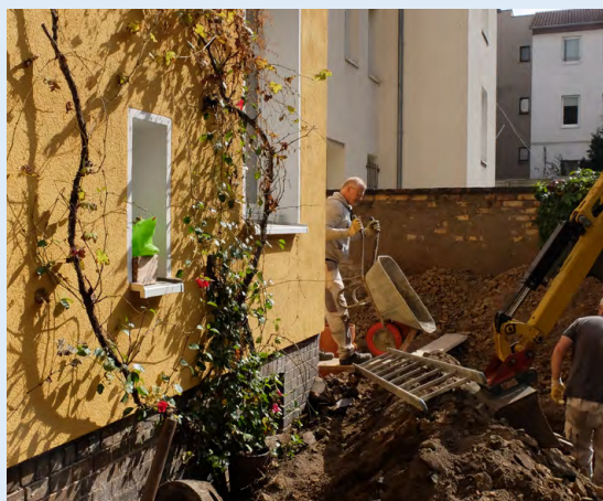
Sanierung der Rohrleitungen, Gartenseite der Merseburger Straße 17
