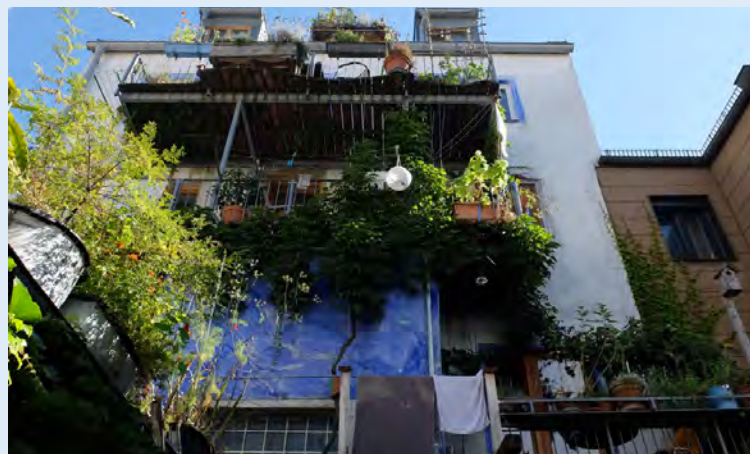
Balkone zum Blockinnenbereich.
