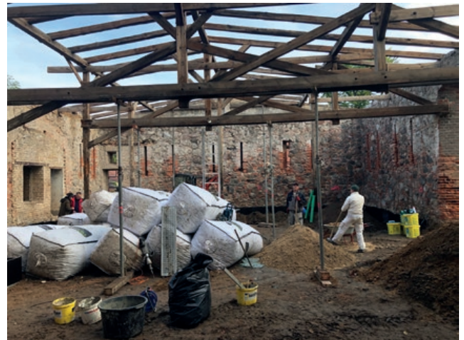
Abb. 84: Entkernung der Kleinen Scheune © Hütten und Paläste
