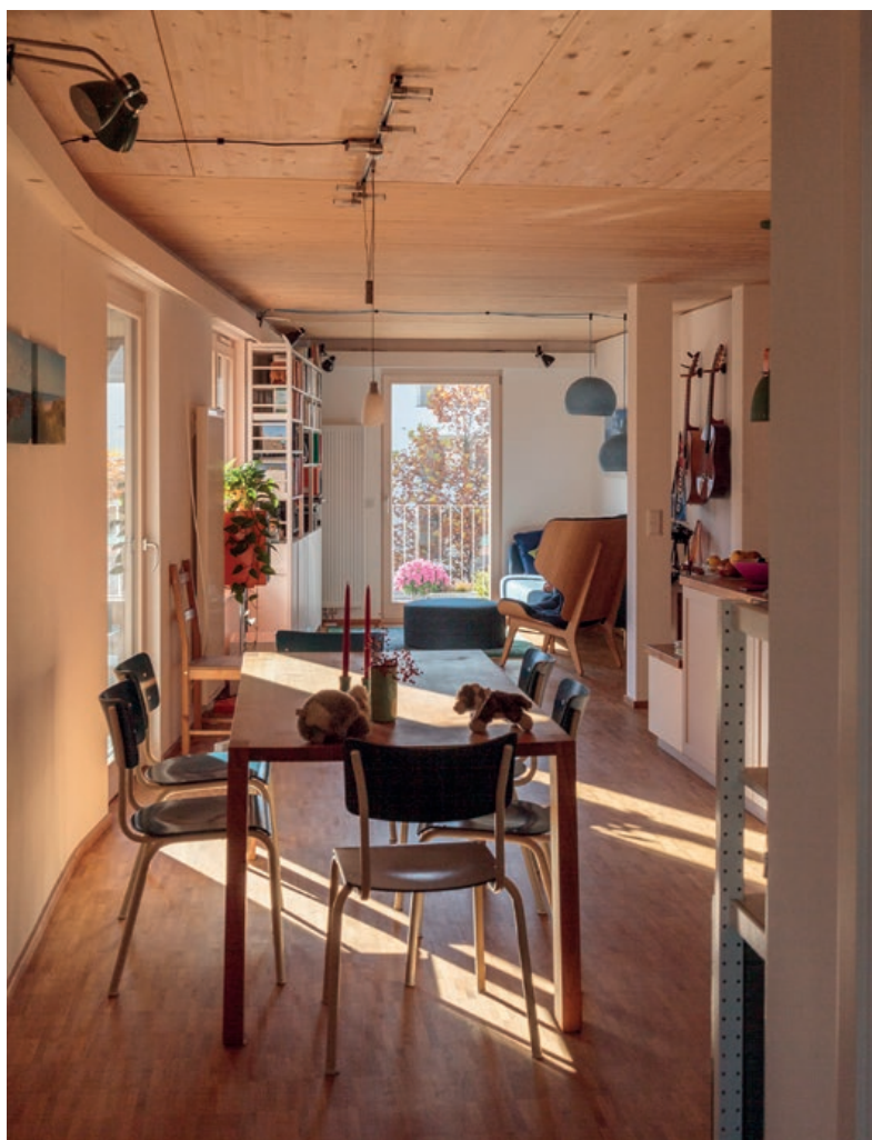
Abb. 169: In den Wohnungen wurde die Elektroinstallation auf den rohen Holzoberflächen verlegt. © Liska Henglein
