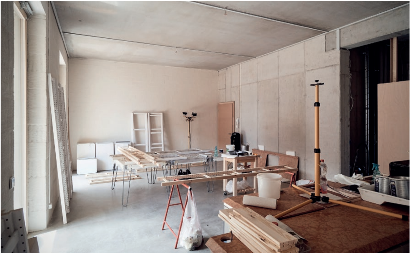
Abb. 100: Selbstausbau in der Praxis © Roland Schmid
