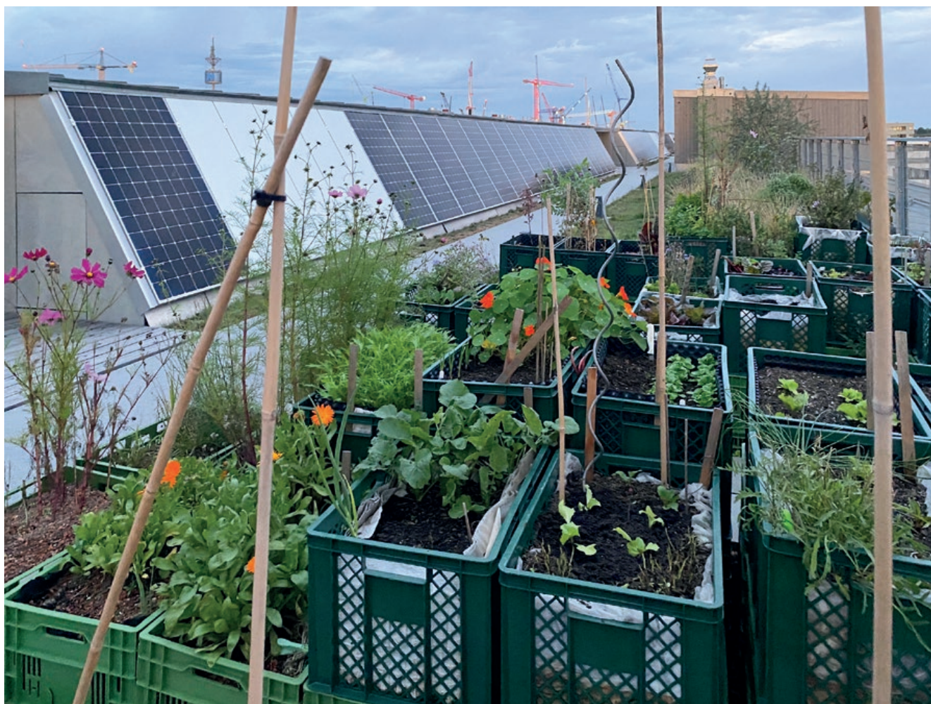
Abb. 165: Dachgarten mit Photovoltaikanlage © Katharina Wildemann
