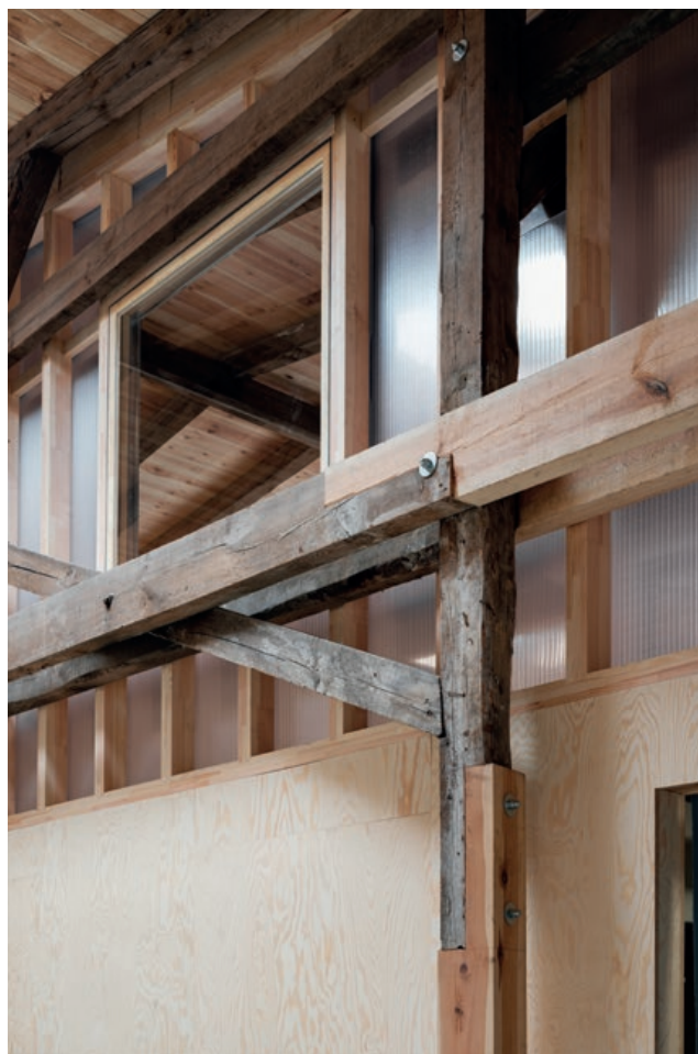
Abb. 21: Beim Umbau der Scheune von 05_Hof Prädikow wurden Bauteile und Materialien sorgsam recycelt, zwischengelagert und im Sinne eines zirkulären Bauens wiederverwendet © Studio Bowie
