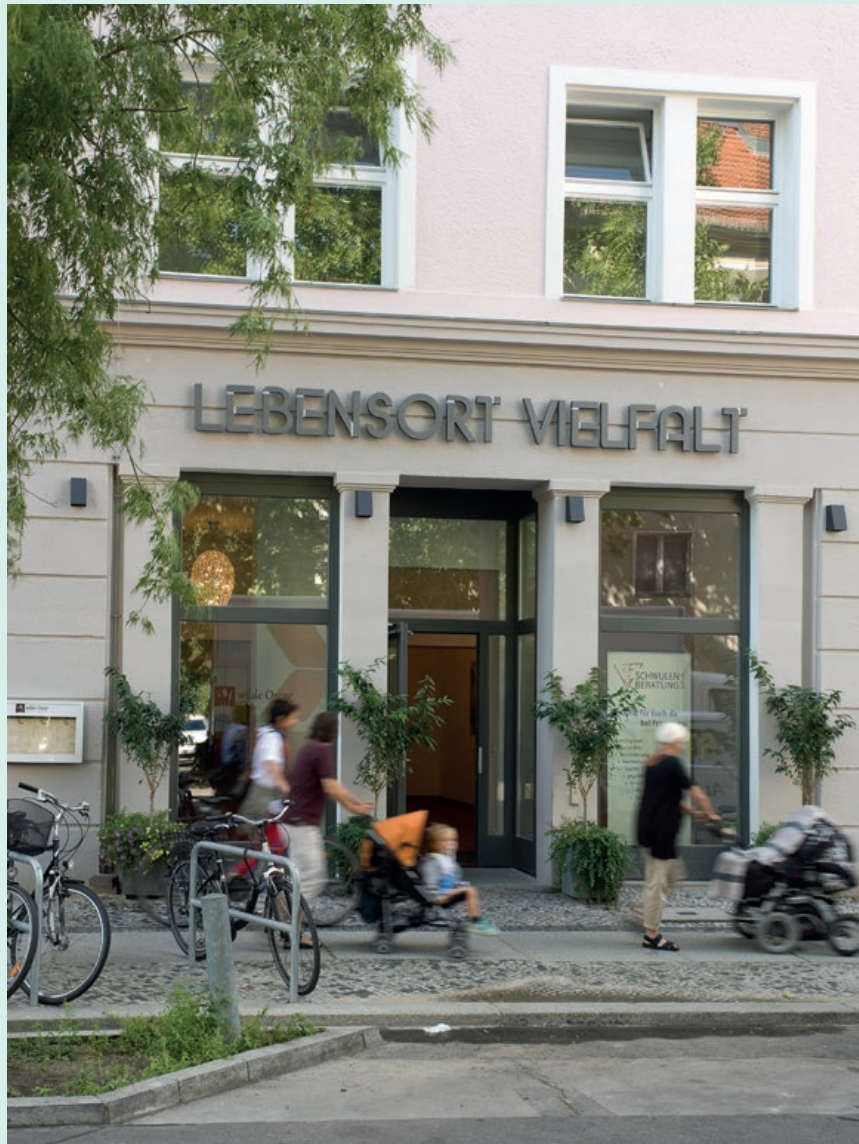
Abb. 57: Eingangsbereich zur ehemaligen Schwulenberatung © Gianni Plescia
