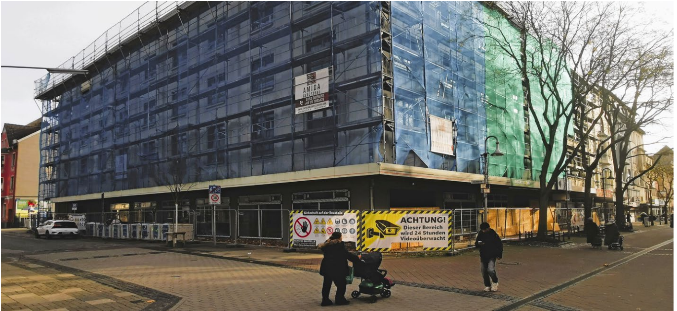
Abb. 5: Umbau des Karstadt-Hauses in Wanne, Stand Dezember 2025 (Foto: Nina Hangebruch)
