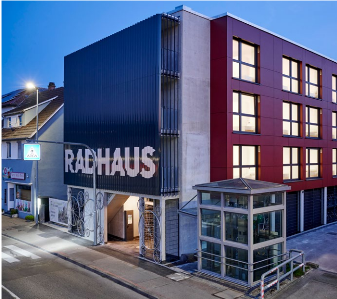
Abb. 2: Wohnheim für Berufsschüler und Auszubildende der nahe gelegenen Berufsschule mit 19 Wohneinheiten und einem öffentlichen Radhaus in Schorndorf. Errichtet in Holzmobulbauweise im EH-40-Standard und QNG-Zertifizierung. Bauherr: Kreisbaugesellschaft Waiblingen GmbH, Hersteller/Planende: Lechner Cube Holzmobulbau GmbH mit a+b Architekten (Bildquelle: Peter Oppenländer)
