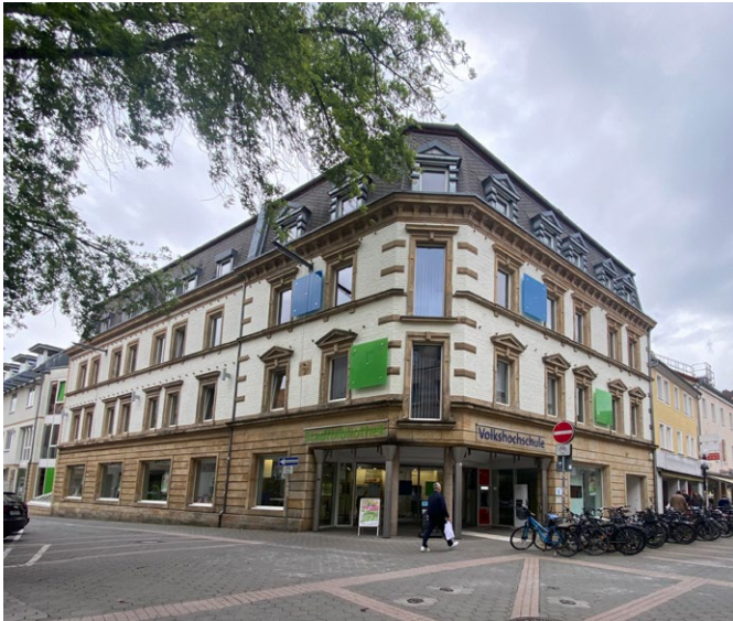
Abb. 3: Kaufhausumnutzung in Bayreuth als Schlusspunkt der Fußgängerzone. Ein Projekt der Stadterneuerung, das maßgeblich zur Stabilisierung des direkten städtebaulichen Umfelds beigetragen hat. (Foto: Körby 2023)
