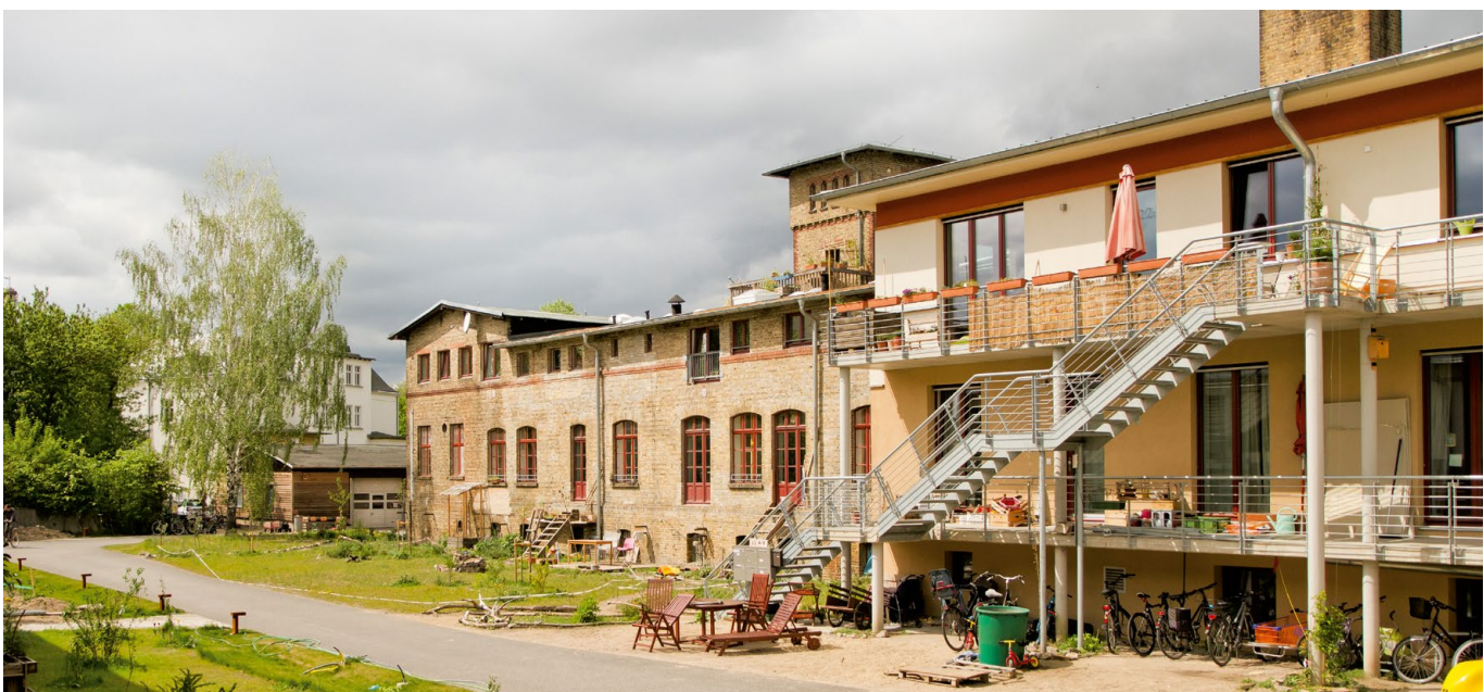
Abb. 1: Die Genossenschaftswohnungen für 170 Menschen auf dem ehemaligen Fabrikgelände im Uferwerk Werder wurden allesamt ökologisch gebaut bzw. saniert. (Foto: Mirko Kubein)
