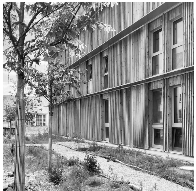
Abb. 5: Das Collegium Academicum in Heidelberg ist ein selbst organisiertes Studierendenwohnheim. Auf einem ehemaligen Kasernengelände nutzt es ein Bestandsgebäude und einen Holzneubau, der nach Suffizienzkriterien organisiert ist. (Foto: subsolar*)
