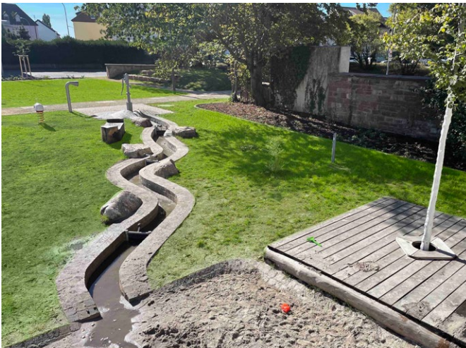
Abb. 2: Wasserspielbereich (Fotos: CS Landschaftsarchitekt)
