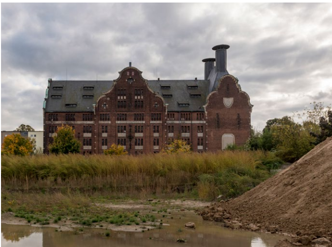
Abb. 1: Ausgangslage: die Alte Mälzerei 2017 (Foto: Erik-Jan Ouwerkerk)
