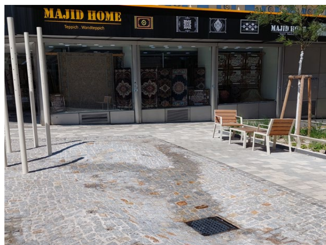
Abb. 2: Schwammstadtelement mit Wasserspiel in der Thaliastraße/Wien
