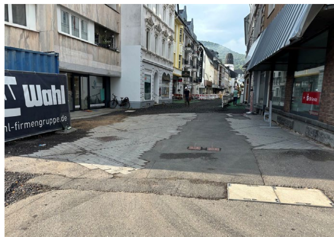
Abb. 3: Zerstörte Fußgängerzone und EG-Zonen in Bad Neuenahr 2024
