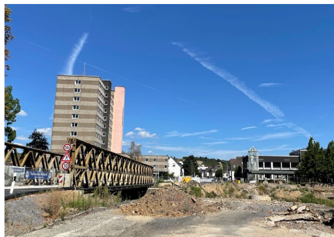
Abb. 2: Behelfsbrücke und Krankenhaus an der Ahr in Bad Neuenahr 2024
