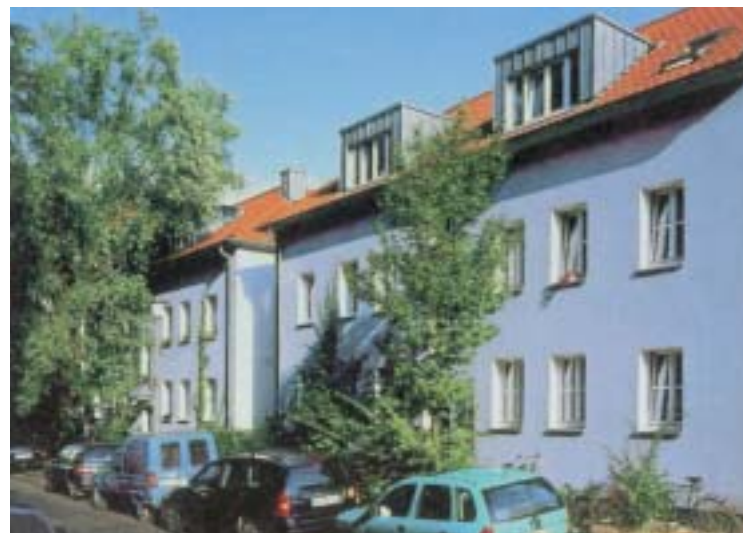
Modernisierung in Selbsthilfe, Breul/Münster
