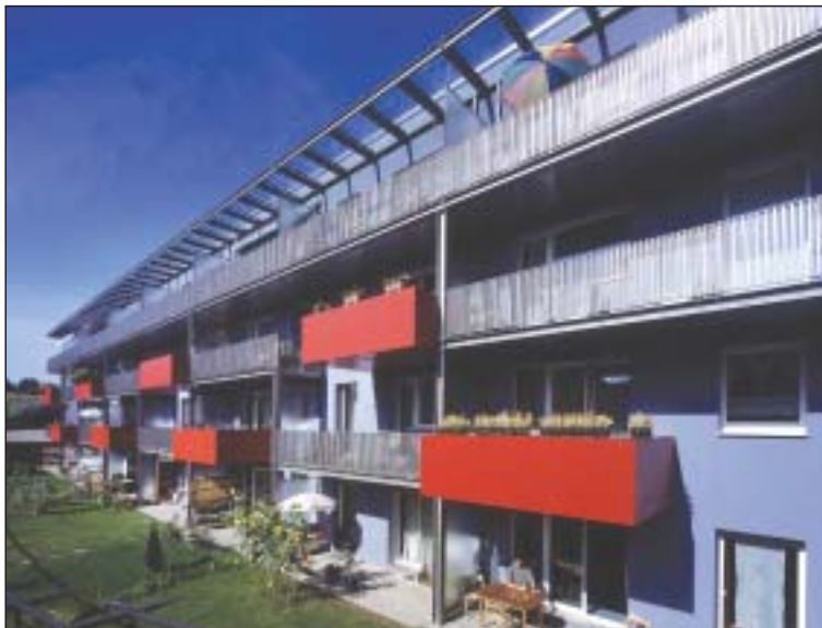
Abb 2: Rückbau eines sechsgeschossigen Plattenbaus auf vier Stockwerke
