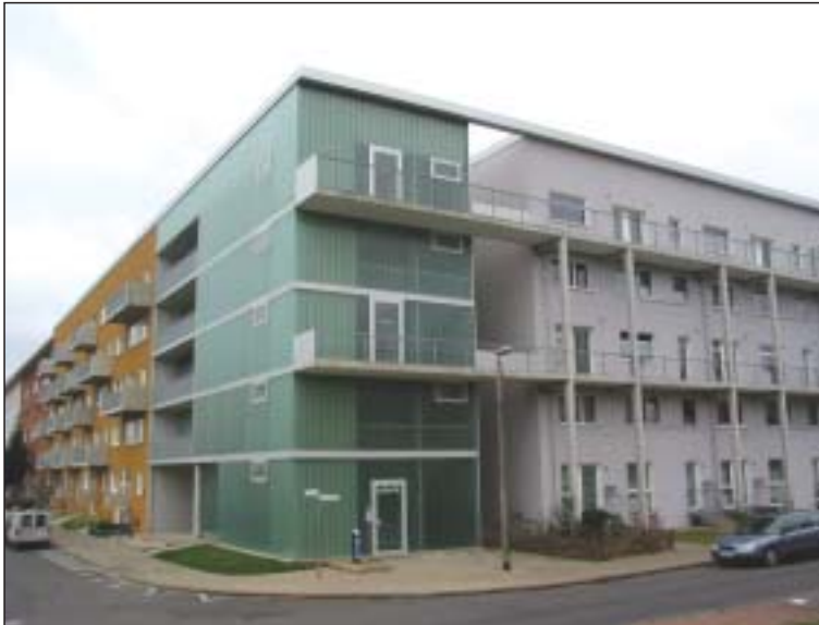
Abb. 4: Erschließungsneubau - barrierefreie Erreichbarkeit aller Wohnungen durch Laubengänge
