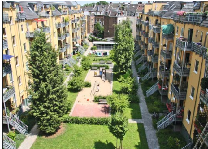
Abb. 2: „Solarsiedlung Riehl“ nach der energetischen Sanierung
