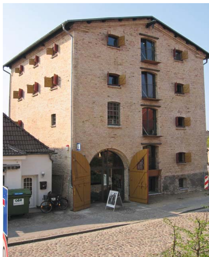
Abb. 4: Historischer Speicher in Klütz, nach der Sanierung (Quelle: Architekturbüro GPK)
