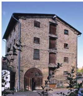
Abb. 3: Historischer Speicher in Klütz, vor der Sanierung (Quelle: Architekturbüro GPK)
