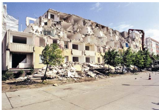
Abb. 1: Gebäudeabriss in Parchim-Weststadt (Quelle: EGS)
