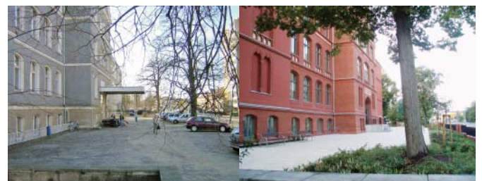
Abb. 6 und 7: Brennergymnasium vor und nach der Sanierung der Fassade und des Umfelds (Fotos: Ruge)
