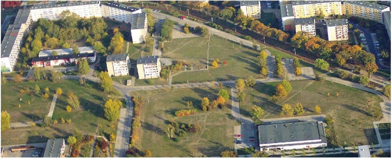
Abb. 8: Flächenhafter Rückbau im Stadtumbaugebiet Neuberresinchen (Foto: Annuß)
