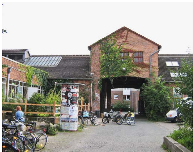
Abb. 5: Das Gelände einer ehemaligen Fabrik wurde unter Mitwirkung eines Vereins, einer Stiftung und der Landeshauptstadt Hannover entwickelt und ist nun öffentlich nutzbar.
