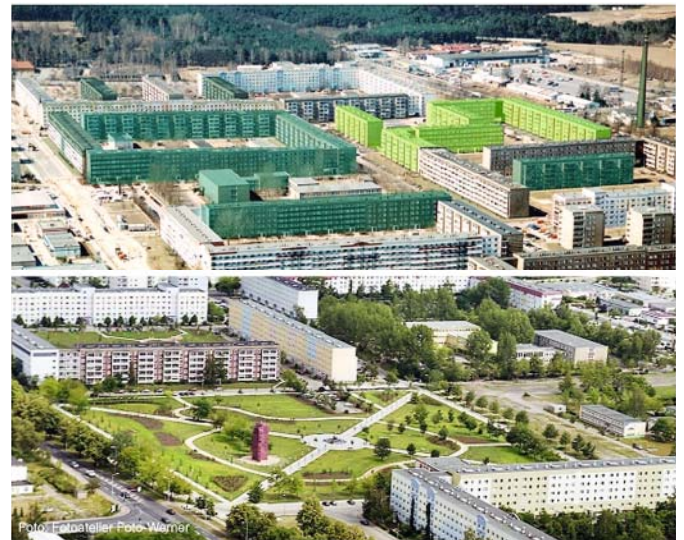
Abb. 5a und 5b: Stadt Guben, Wohnkomplex vor und nach Stadtumbau
