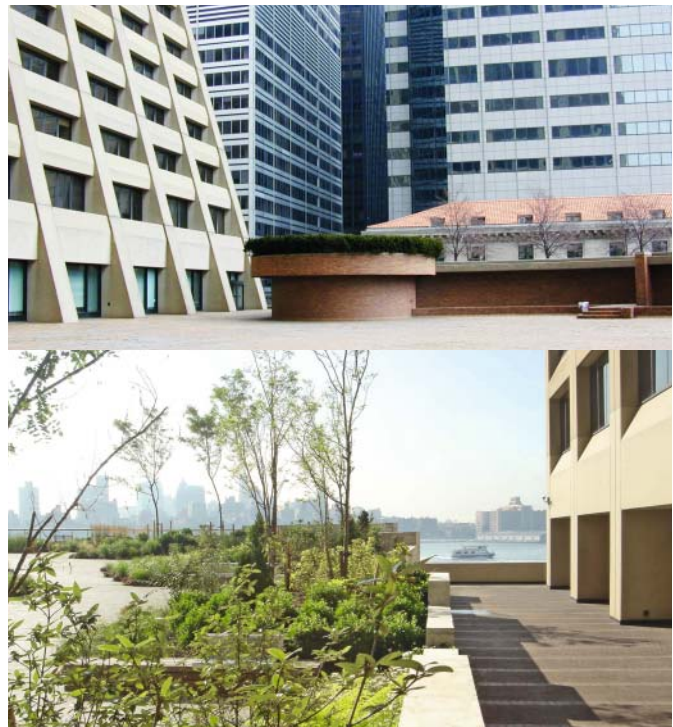
Abb. 6: 55 Water Street – vorher (oben), nachher (unten)
