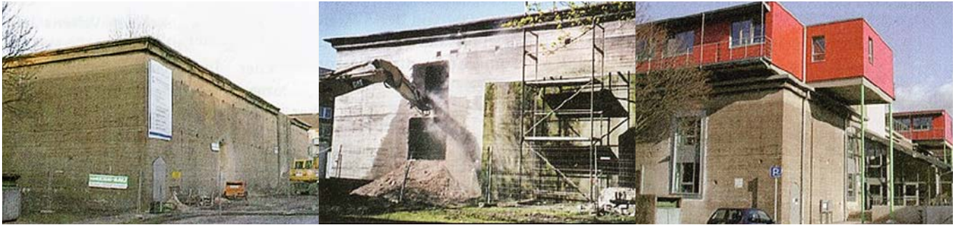
Abb. 6: Bürgerzentrum auf dem Hochbunker „Alte Heid“ (Quelle: Stadt Oberhausen )
