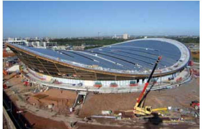
Abb. 5: Baustelle Olympia (Quelle: ODA)
