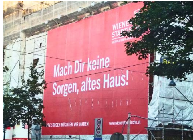
Abb. 2: Baustelleneinrüstung in Wien
