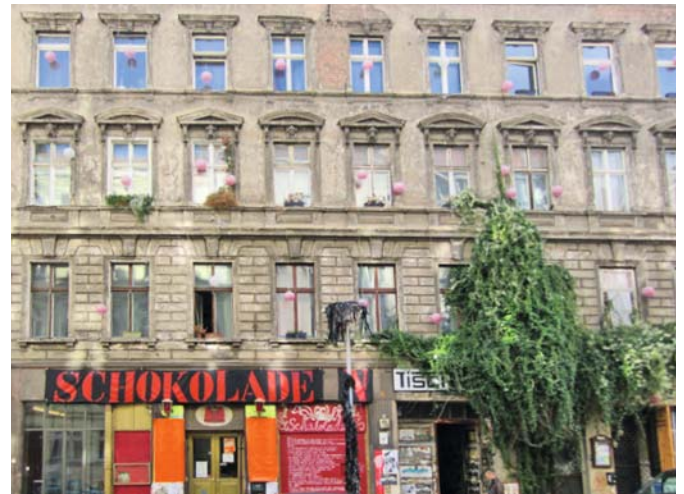
Abb. 1: Klimabaustelle Wohnungsbestand (Fotos: Annick Rietz)
