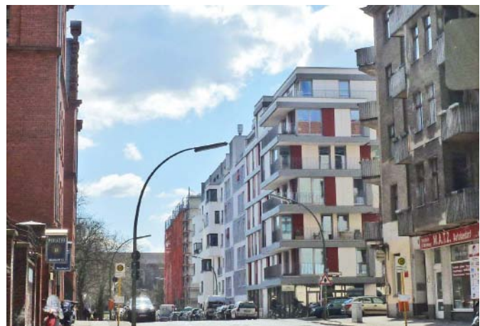
Abb. 4: Wohngebäude Baugemeinschaften – Friesenstraße
