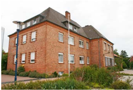
Abb. 2: Ehemalige Schule in Marklohe vor dem Umbau zur Kinderbetreuungseinrichtung (Foto: Plan und Praxis)
