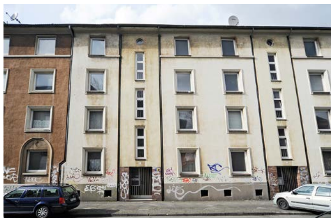
Abb. 3: Haus in der Nettelbeckstraße (Projekt Lebenshilfe)
