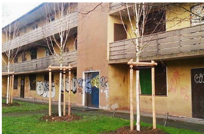
Abb. 2: Neue Bäume vor mit Stahlplatten verriegelter Schrottimobilie
