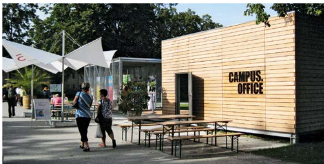
Abb. 1: campus.office auf der Landesgartenschau in Aschersleben
