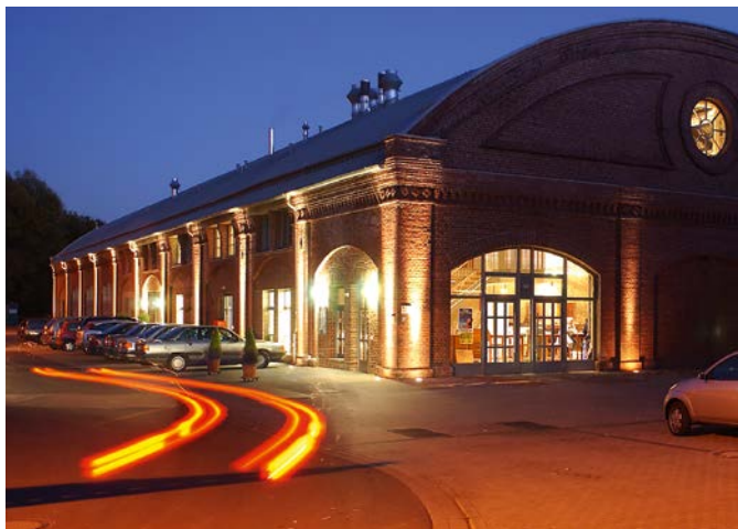
Abb. 1: Die Rohrmeisterei in Schwerte
