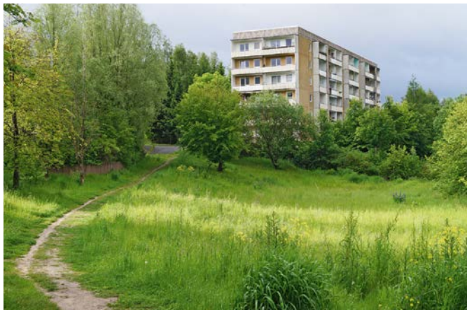
Abb. 4: Allgegenwärtiges Nebeneinander von Abrissflächen und Wohngebäuden in Suhl-Nord
