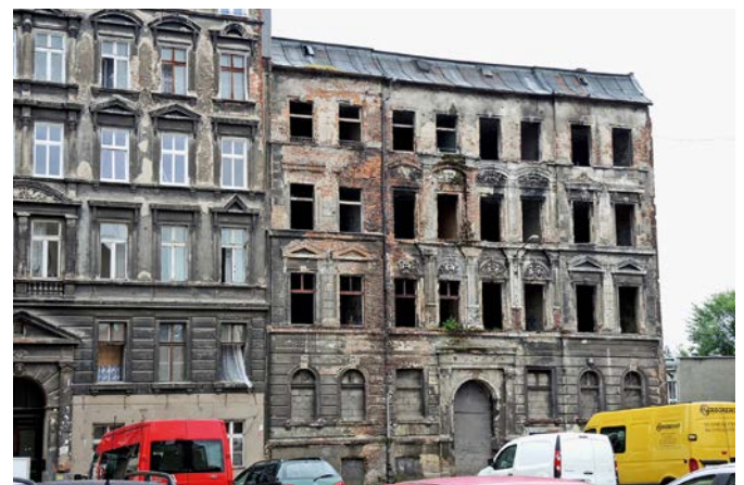
Abb. 1: Unsanierter Altbau (Fotos: Jost)
