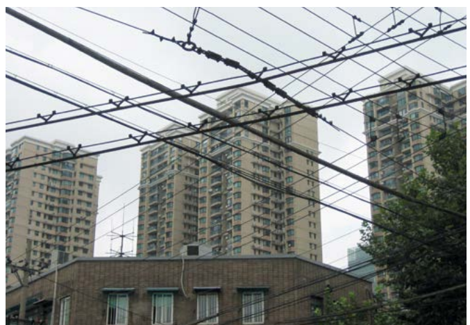
Abb. 1: Infrastruktur für Elektromobilität im ÖPNV – hier: Oberleitungen für O-Busse in Schanghai (Foto: Jost)
