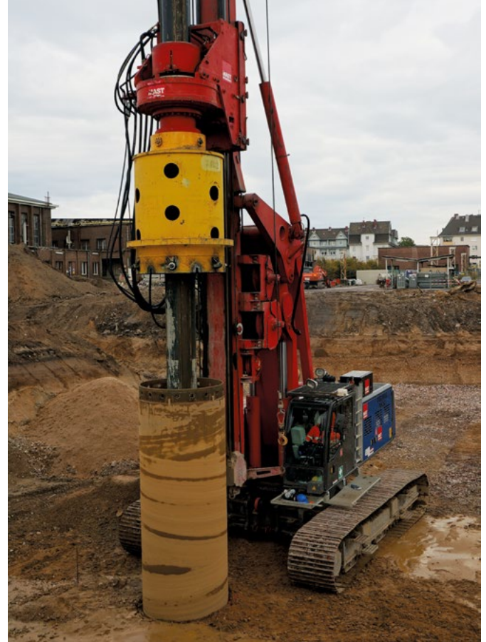
Abb. 1: Bodensanierung auf einem ehemaligen Industrieareal in Köln (Clouth-Quartier)
