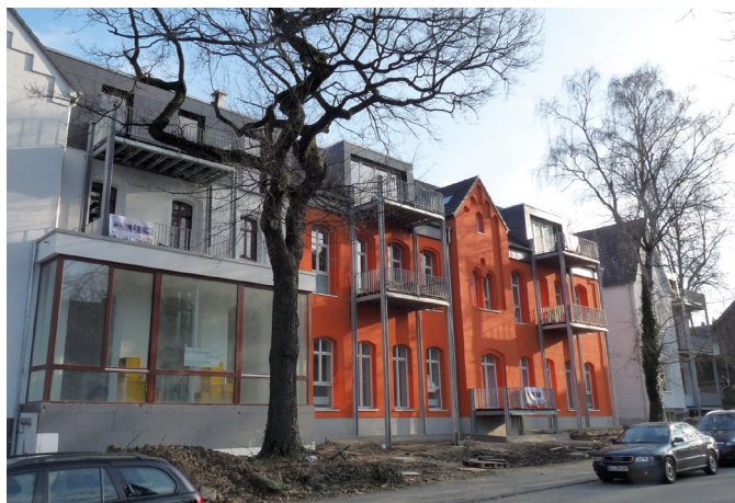
Abb. 2: Riesaer Str. 30 in Dresden: Zentralwerk, Kultur- und Wohngenossenschaft Dresden eG; Wohnen und Atelier, Kunst, Kultur und Quartiersarbeit
