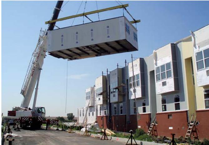
Abb. 2: Aktueller Hausbau in Form von Modulen
