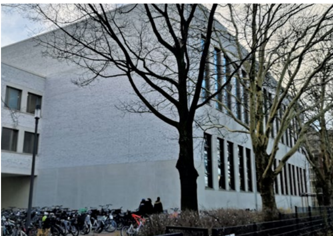
Abb. 5: Übereinander angeordnete Sporthallen des Gymnasiums Hoheluft in Hamburg
