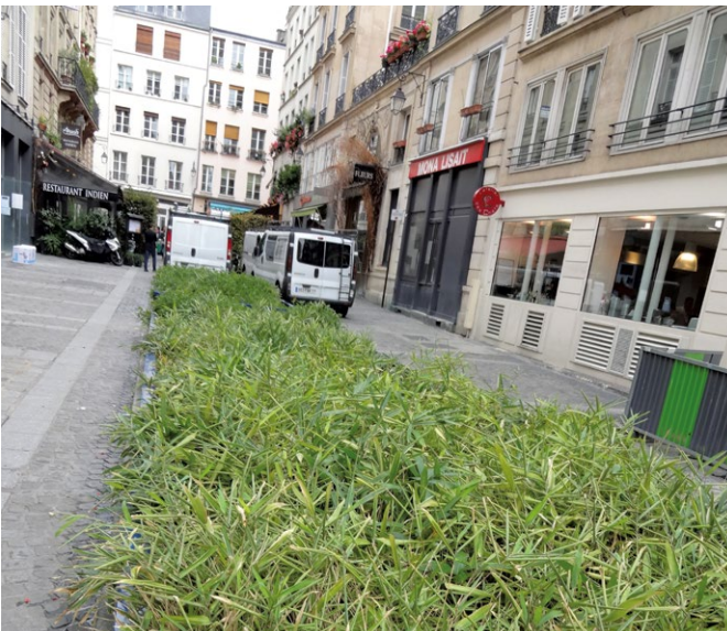
Abb. 6: Verdunstungsbeete im Straßenraum von Paris: in Hitzeperioden werden diese ‚Kühlschränke‘ mit Wasser gefüllt. (Foto: bgmr)
