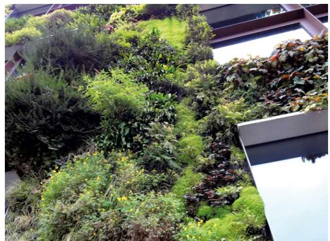
Abb. 5: Vertikaler Kühlraum, Paris (Foto: bgmr)
