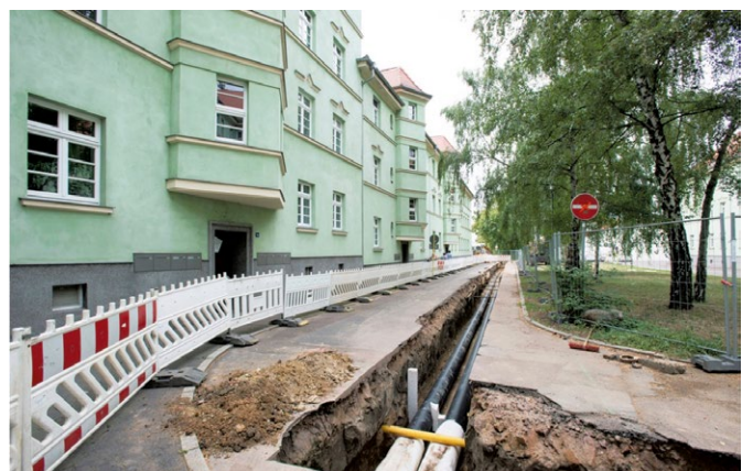
Abb. 1: Die Energiewende im Quartier hat viele Dimensionen und Gesichter: Sie zeigt sich wie hier im Haller Lutherviertel aus den 1920er Jahren, wo Leitungsgräben für neue Wärmenetze gegraben werden. (Foto: BBSR)
