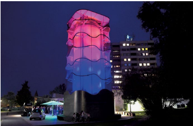
Abb. 2: Erprobung neuer Technologien, hier in einer Großwohnsiedlung aus den 1960er Jahren mit einem neuen 300 m 3 Wärmespeicher als Herzstück des zukunftsweisenden Umbaus der Wärmeversorgung – fast schon ein neues Wahrzeichen des Stadtteils Hildesheim-Drispstedt. (Foto: plan zwei)
