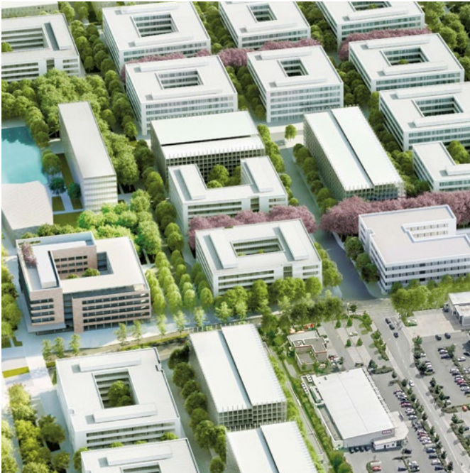
Abb. 3: Campus Erlangen (© Siemens AG)
