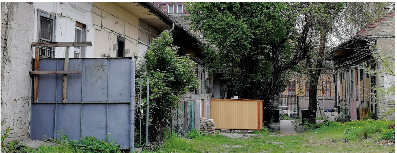
Abb. 1: Typischer Anblick in der Danko Straße vor den Sanierungsarbeiten (Fotos: Géza Salamin)
