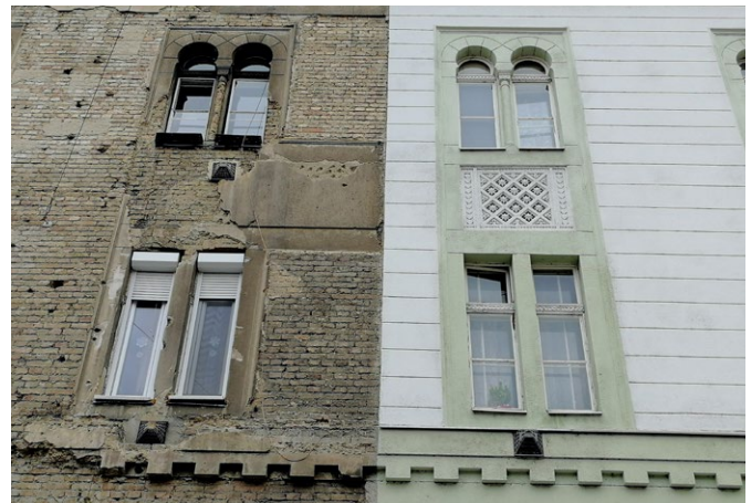
Abb. 2: Ansicht von Häusern vor und nach der Sanierung
