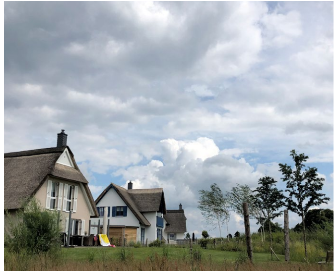
Abb. 4: Siedlungserweiterung in dörflicher Lage in Anlehnung an regionale Bauweise (Foto: LGE)
