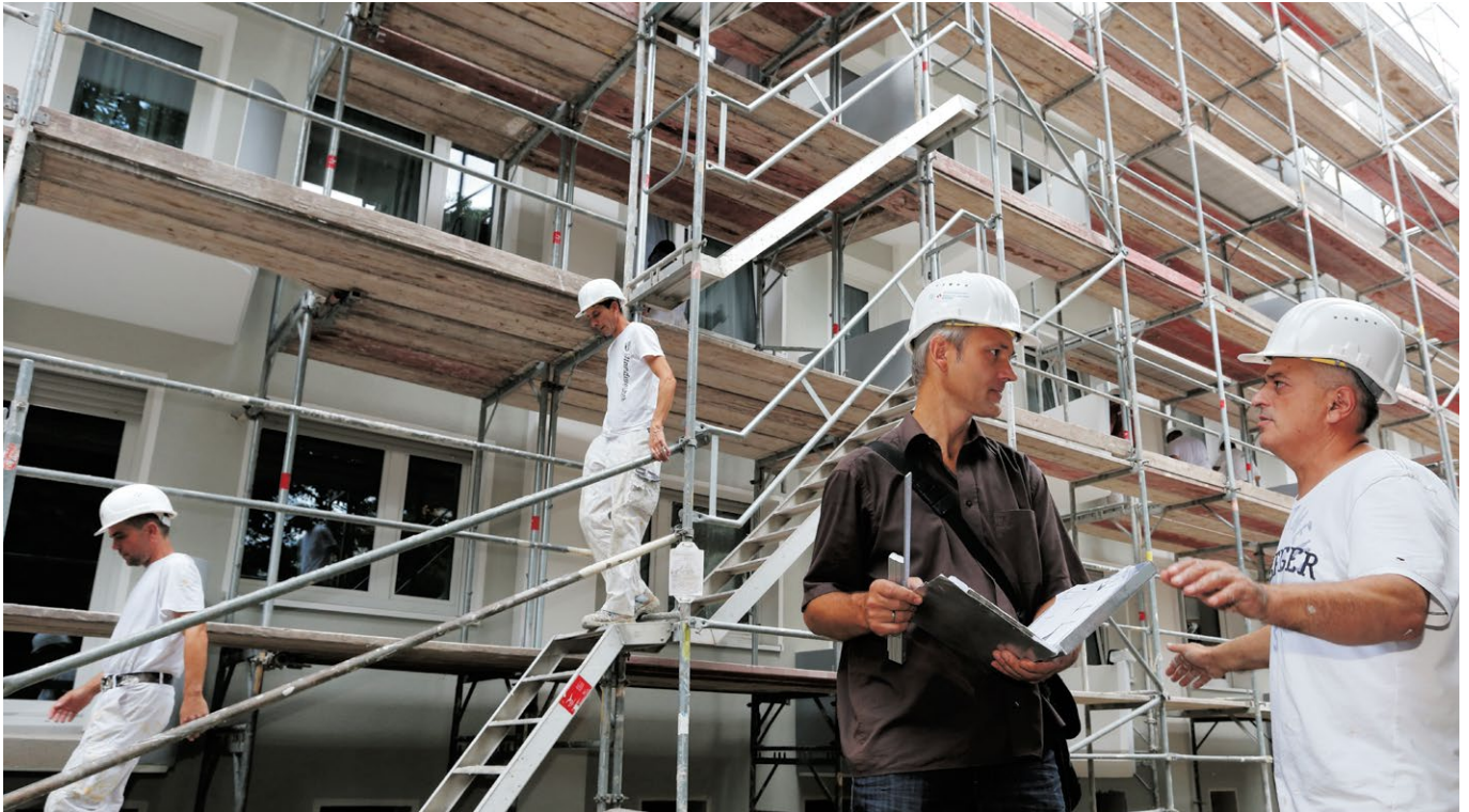
Abb. 1: Auf den Baustellen der Unternehmensgruppe Nassauische Heimstätte | Wohnstadt gibt es viel zu tun: Nach der derzeit gültigen Wirtschaftsplanung stehen dem Konzern für die nächsten fünf Jahre rund 134 Mio. Euro jährlich für Modernisierung und Instandhaltung zur Verfügung. (Foto: NHW/Thomas Rohnke)
