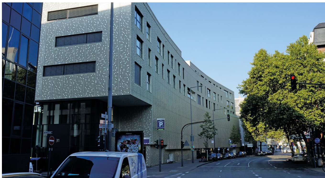
Abb. 1: Parkhaus in der Magnusstraße in Köln: Oben sieht man die Wohnungen (Fenster), unten das Parkhaus. (Foto: Bernhard Hoffmann)
