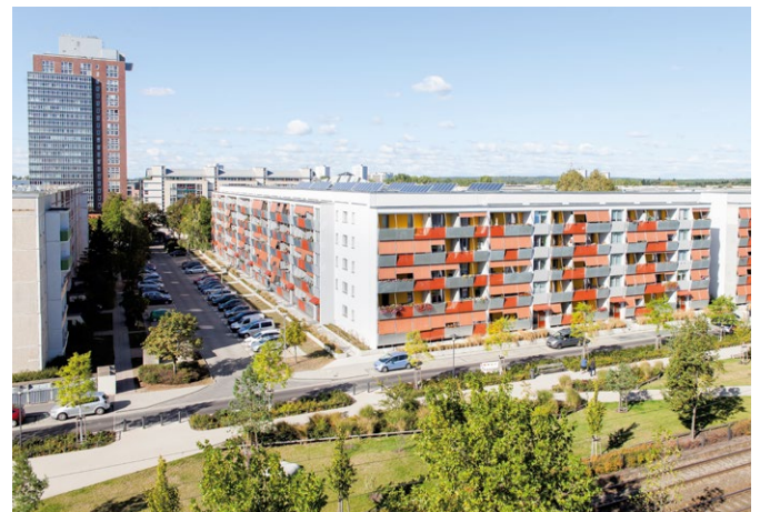
Abb. 7: Sanierung des „Pilotblocks“ – nachher (Foto: Adam Sevens/ProPotsdam)
