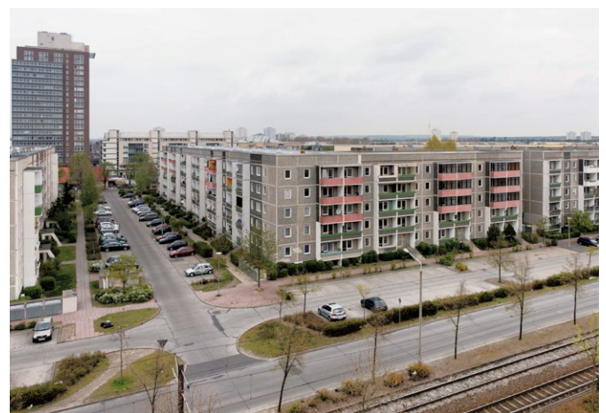
Abb. 6: Sanierung des „Pilotblocks“ – vorher (Foto: Ulf Böttcher/ProPotsdam)
