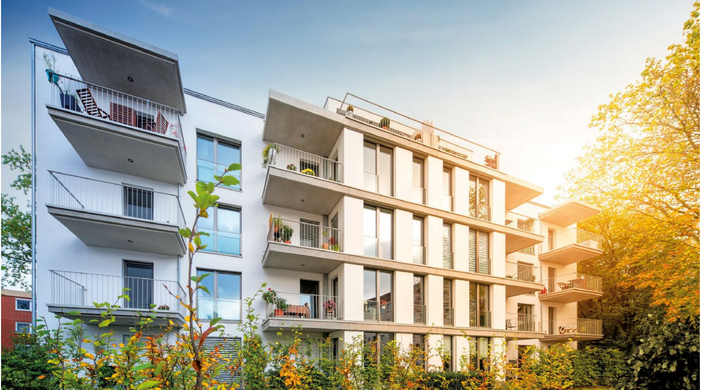
Abb. 5: GEWOBA Neubau Passivhaus in Bremen-Findorff
