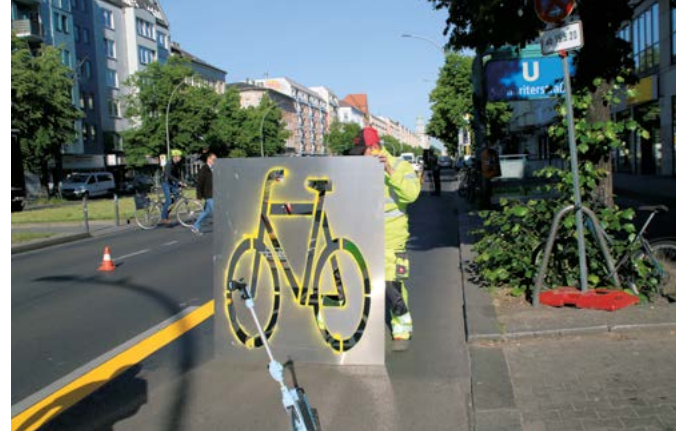
Abb. 3: Schablone für die Markierung der Radwege
