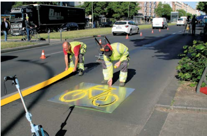
Abb. 2: Markierungsarbeiten in der Frankfurter Allee in Friedrichshain
