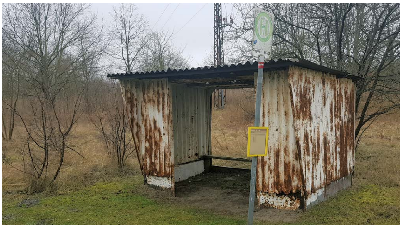
Abb. 1: Oft ein Manko gering verdichteter ländlicher Regionen ist eine schlechte Anbindung mit öffentlichen Verkehrsmitteln an die Oberzentren (Foto: Jost)
