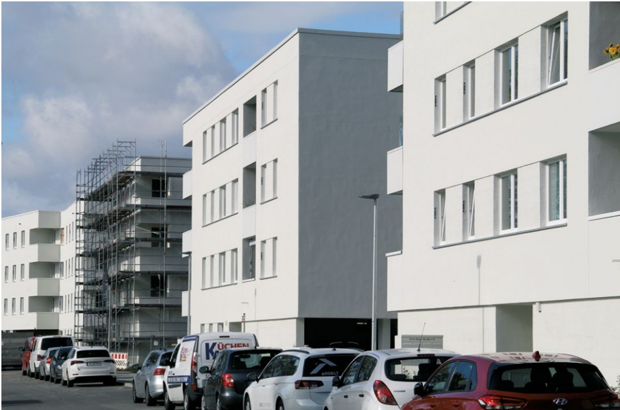
Abb. 7: Neubauvorhaben der städtischen Wohnungsbaugesellschaft in der „Weißen Stadt“ mit vom Land Brandenburg geförderten Wohnraum (Foto: Kielczynski)
