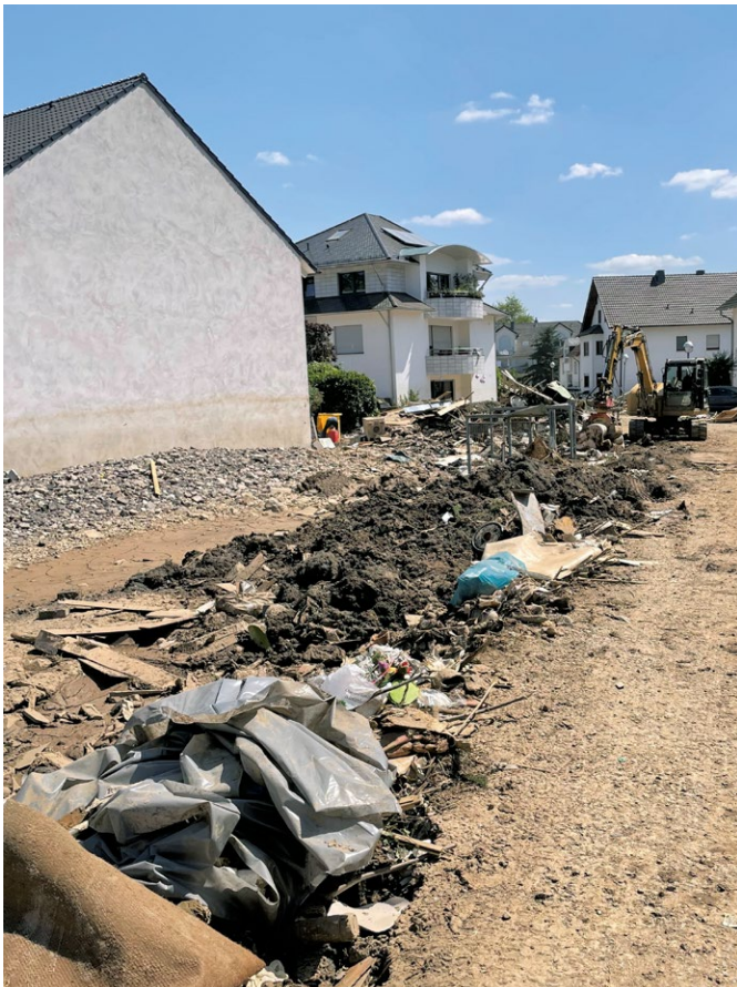
Abb. 1: Hier war mal eine Straße (Fotos: Norbert Portz)
