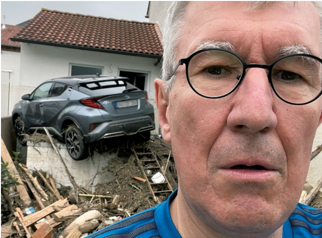
Abb. 5: Zerstörung überall – Strategien zur Schadensvermeidung und -minimierung erforderlich
