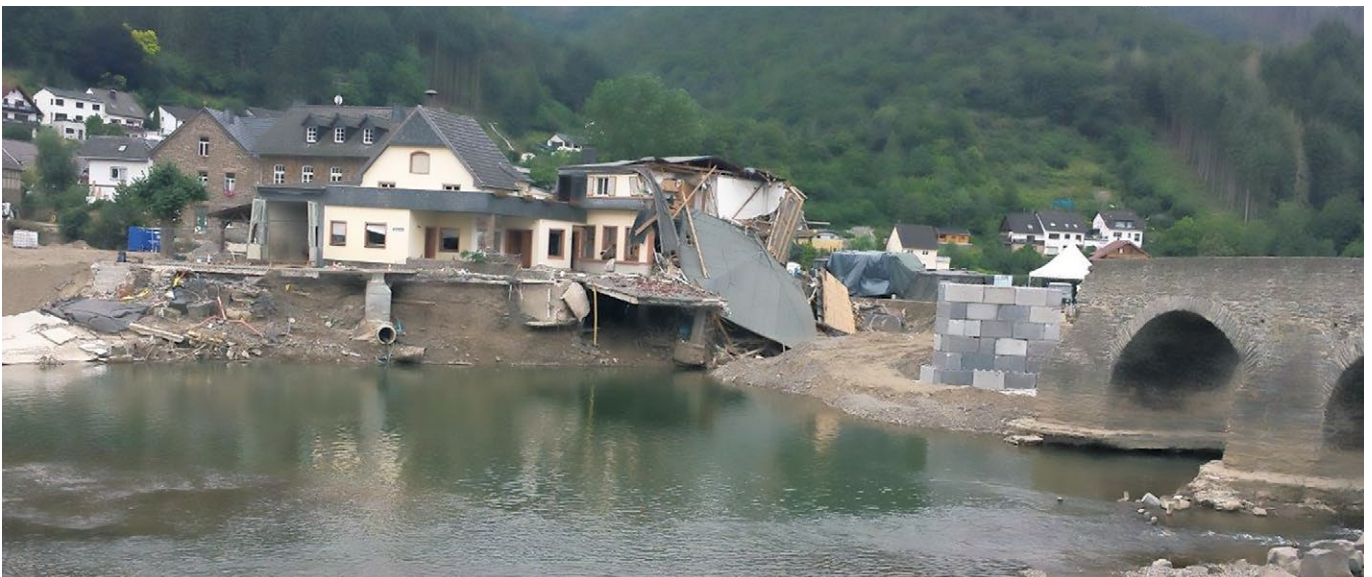
Abb. 1: Die Ahrbrücke oder Nepomukbrücke in Rech, einer Ortsgemeinde im Landkreis Ahrweiler, ist eine Steinbogenbrücke über die Ahr und seit 1981 ein geschütztes Kulturdenkmal (Fotos: Stefan Raetz).
